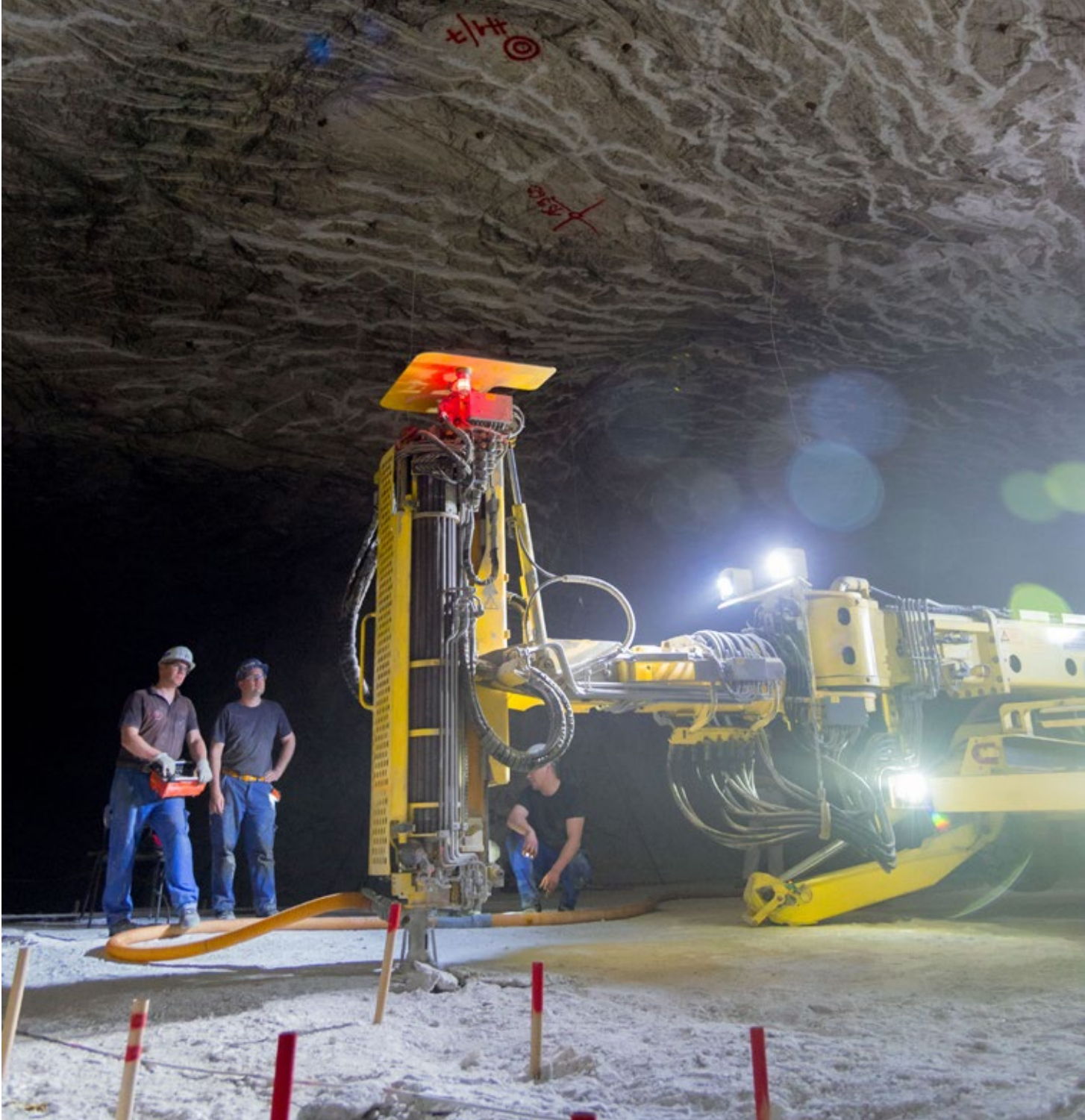
Der Strossenbohrwagen wird für das Sprenglochbohren bei großen Lagermächtigkeiten eingesetzt. Mit modernster Technik werden über 30 Meter lange, senkrechte Sprengbohrlöcher erstellt.
