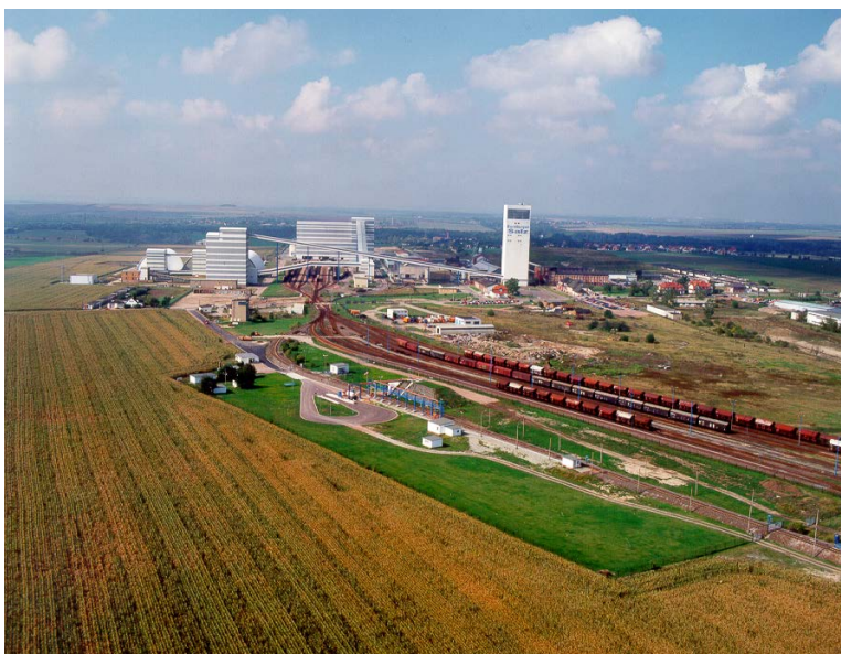
Abbildung 2: Werk Bernburg, im Vordergrund Flüssiggasspeicher- und Umschlaganlage
