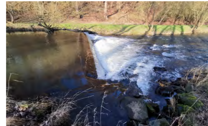
Früher bestand das Wehr bei Räsa aus einer hohen Staustufe aus Beton
