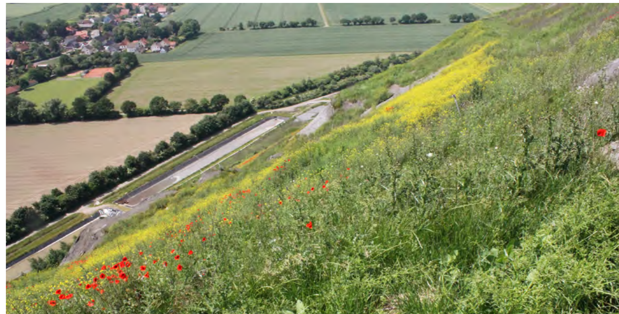
Eine Haldenbegrünung nimmt Regenwasser auf und reduziert die Entstehung salzhaltiger Haldenwässer
