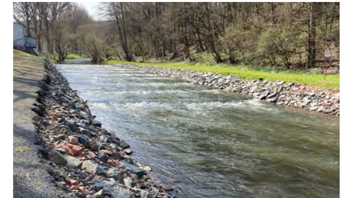
Heute sind hier mehrere Natursteinriegel, die die Fische überwinden können
