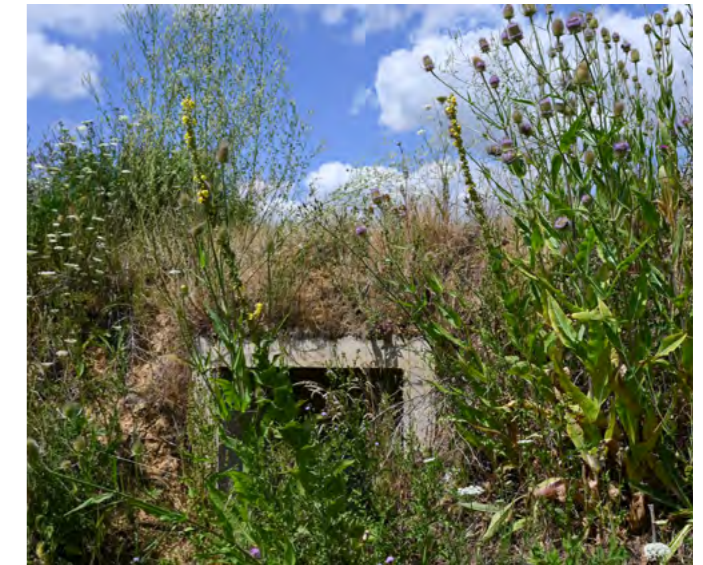
Am Fuße der begrüneten Halde Friedrichshall wurde ein Fledermausbunker integriert
